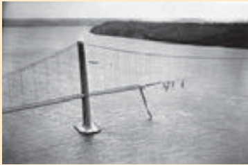
FIGURA 1 Colapso del puente de Tacoma Narrows
